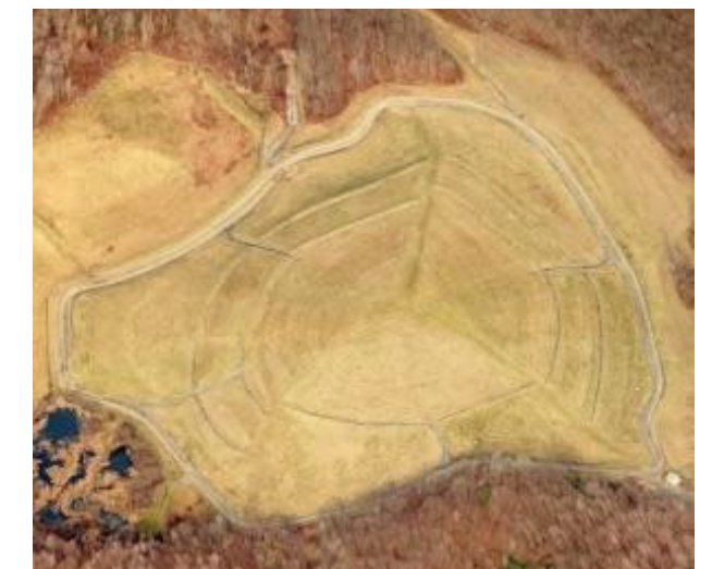
Laurel Park Landfill
